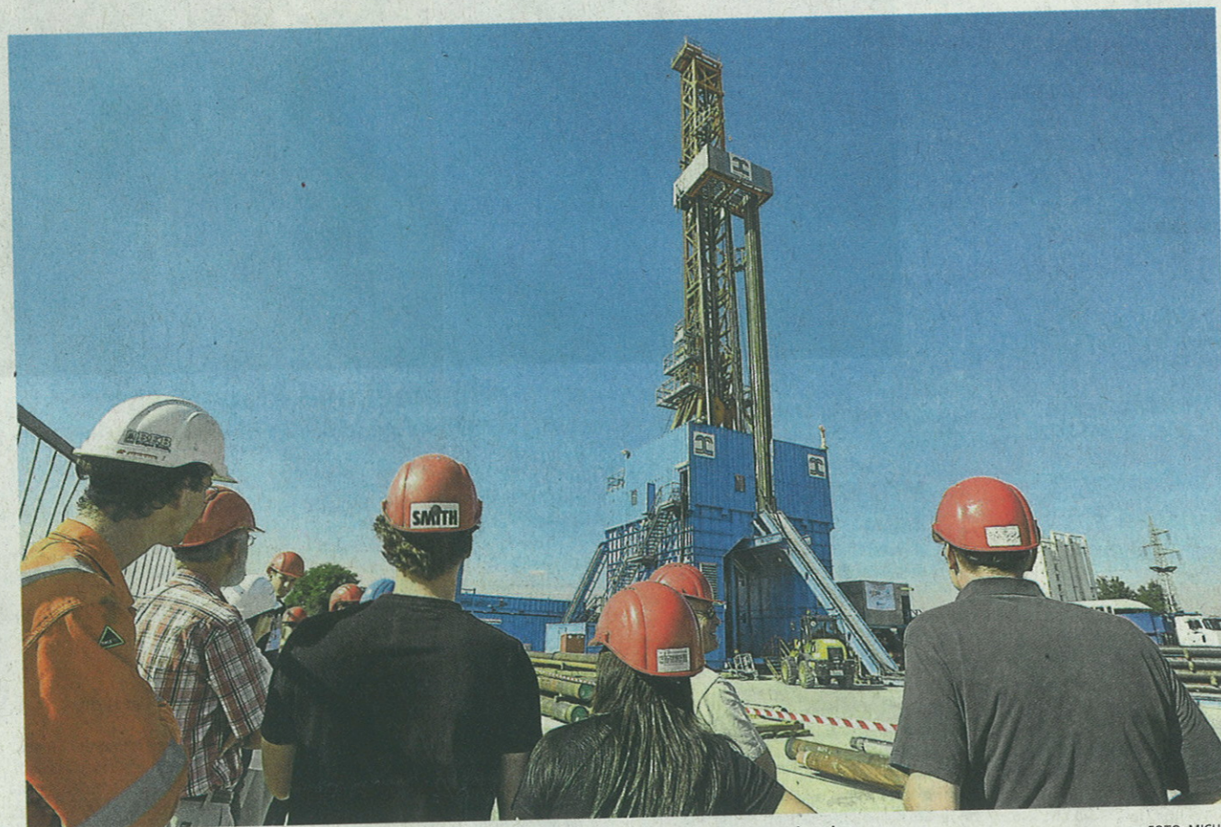
Interessierte Besucher beim „Oberhachinger Wärmetag“ am Geothermie-Bohrplatz.
